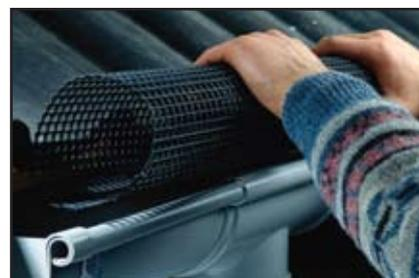
Сетчатая труба Poly-Net Laubstop устанавливается в водосточный желоб и фиксируется там за счет собственной эластичности. Легко обрабатывается, так как Marley Poly-Net Laubstop поставляется длиной в 2,00 м.
